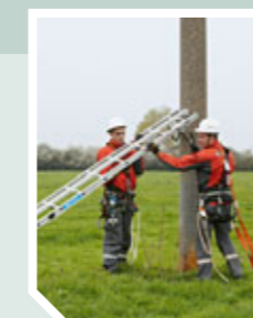
Anbringung der Unterleiter
