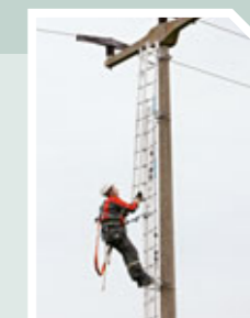
Anbringung der höhenverstellbaren Oberleiter
