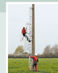
Anbringung der zweiten Mittelleiter
